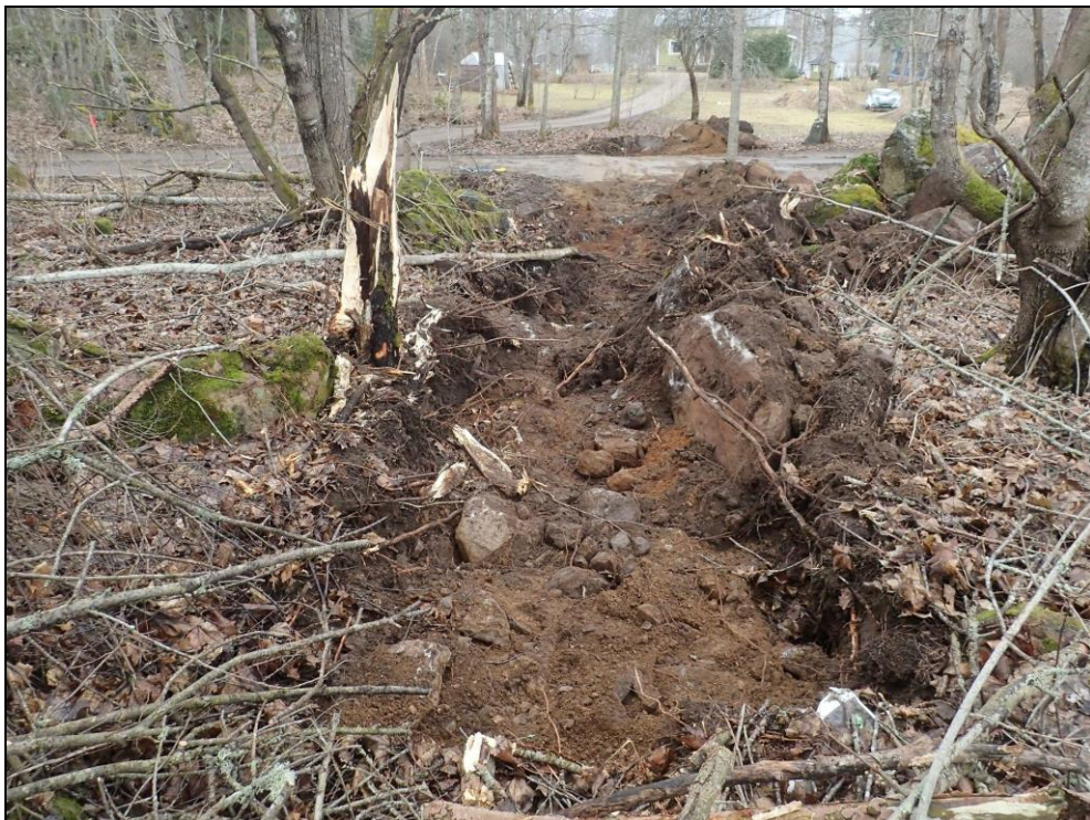
Valmis kaivanto. Lounaaseen.
